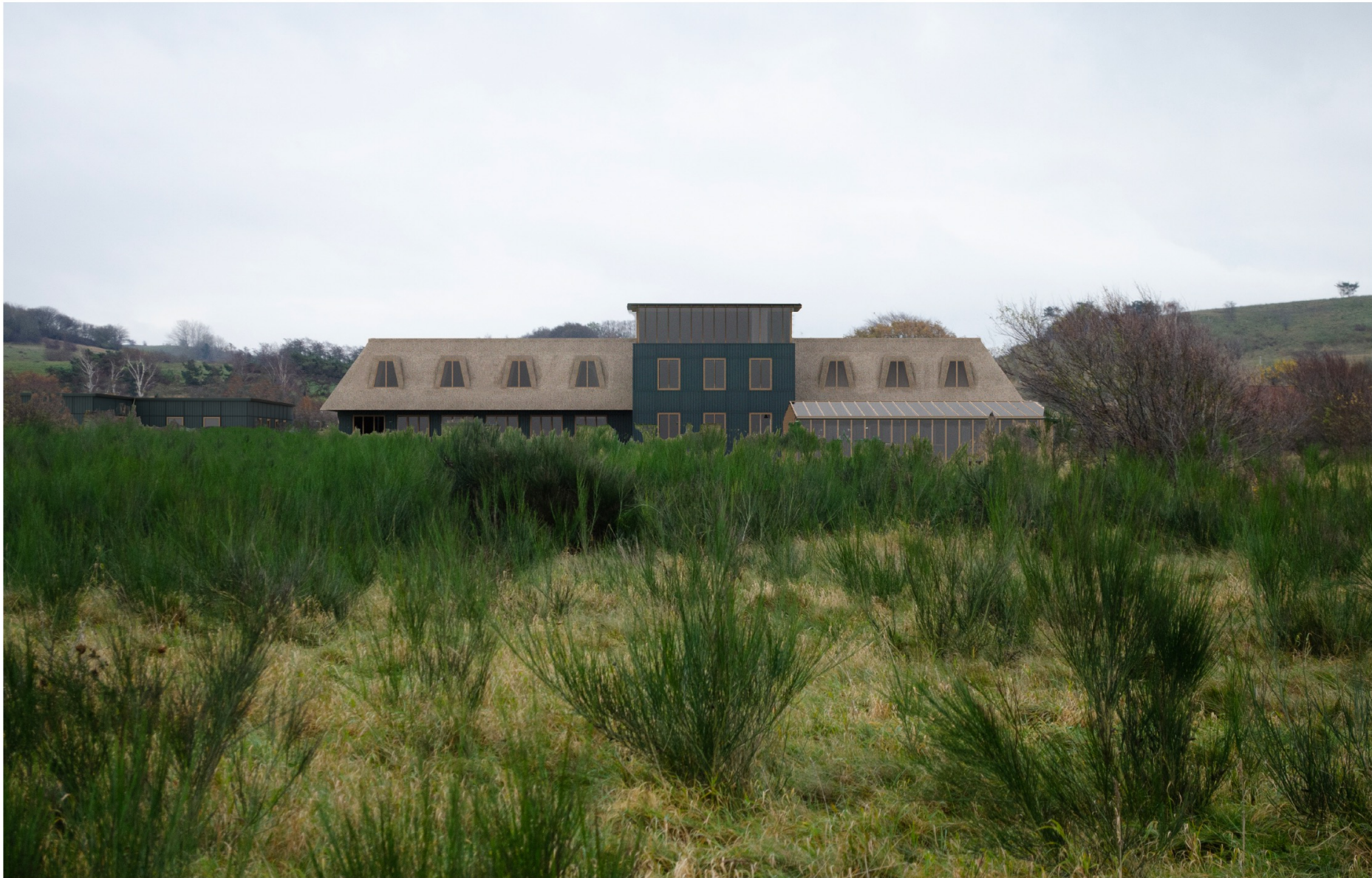
Eksisterende bygning set fra nordøst.
